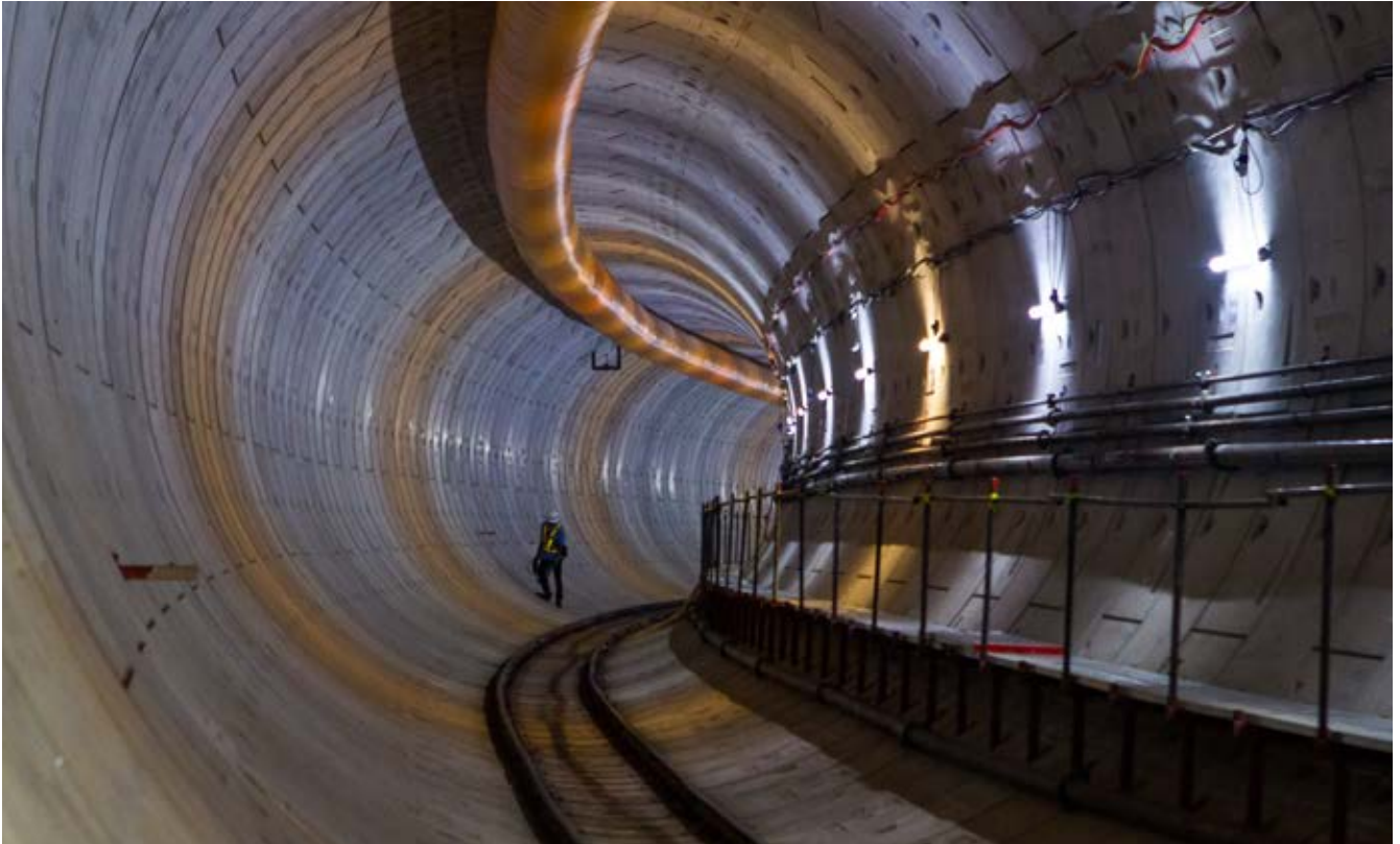
Gambar 4.6 Tunnel MRT Jakarta
