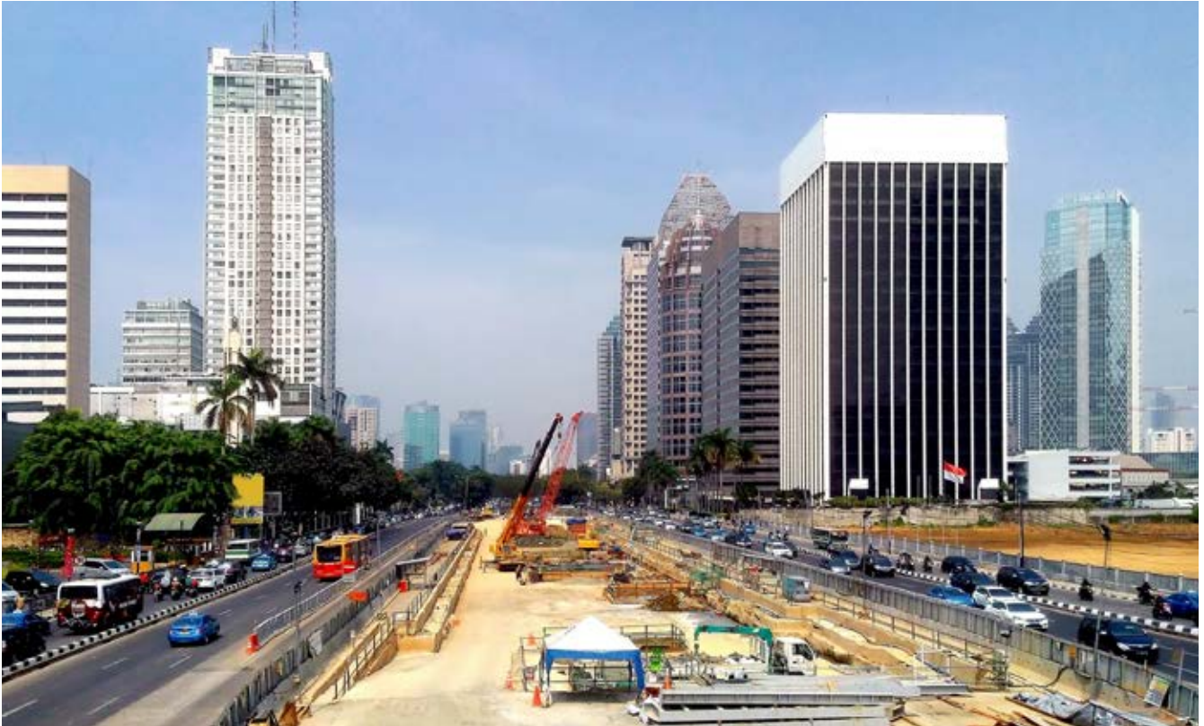
Gambar 4.5 Pembangunan MRT Jakarta
